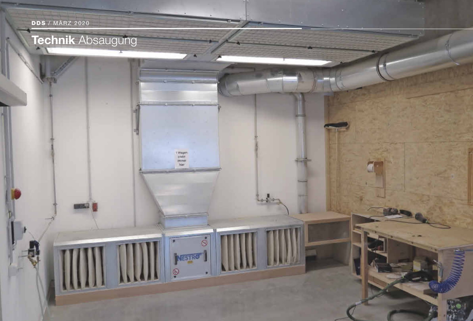
Saugt den Lacknebel ab: Nestros Paintline System OF 85
