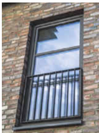
... so konnten diese unter optimalen Bedingungen montiert und abgedichtet werden
