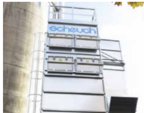
Scheuch LIGNO hat bei der Tischlerei Schneider eine neue Absaugung mit einer Leistung von 23.000 m 3 /h eingebaut. (Foto links)
