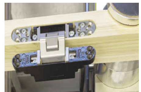
Thomas Mendl kontrolliert, ob das Band tatsächlich in die Fräsung passt
