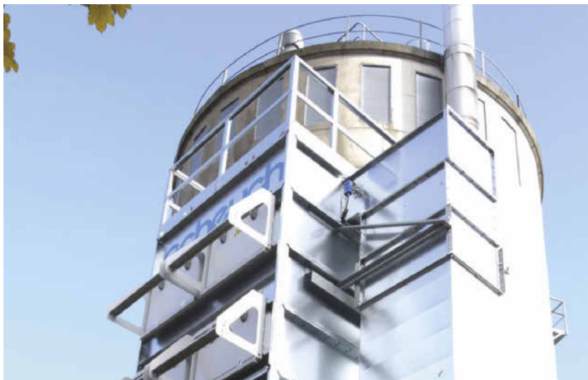
Scheuch LIGNO hat bei der Tischlerei Schneider eine neue Absaugung mit einer Leistung von 23.000 m 3 /h eingebaut. (Foto links)
