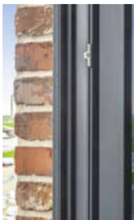
Das Verblendmauerwerk wurde erst nach den Fenstern eingebaut ...
