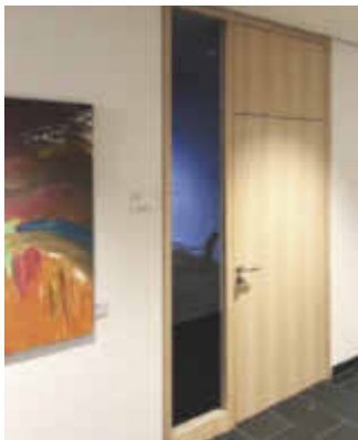
Die wandflächenbündige Bürotür öffnet in die Laibung hinein
