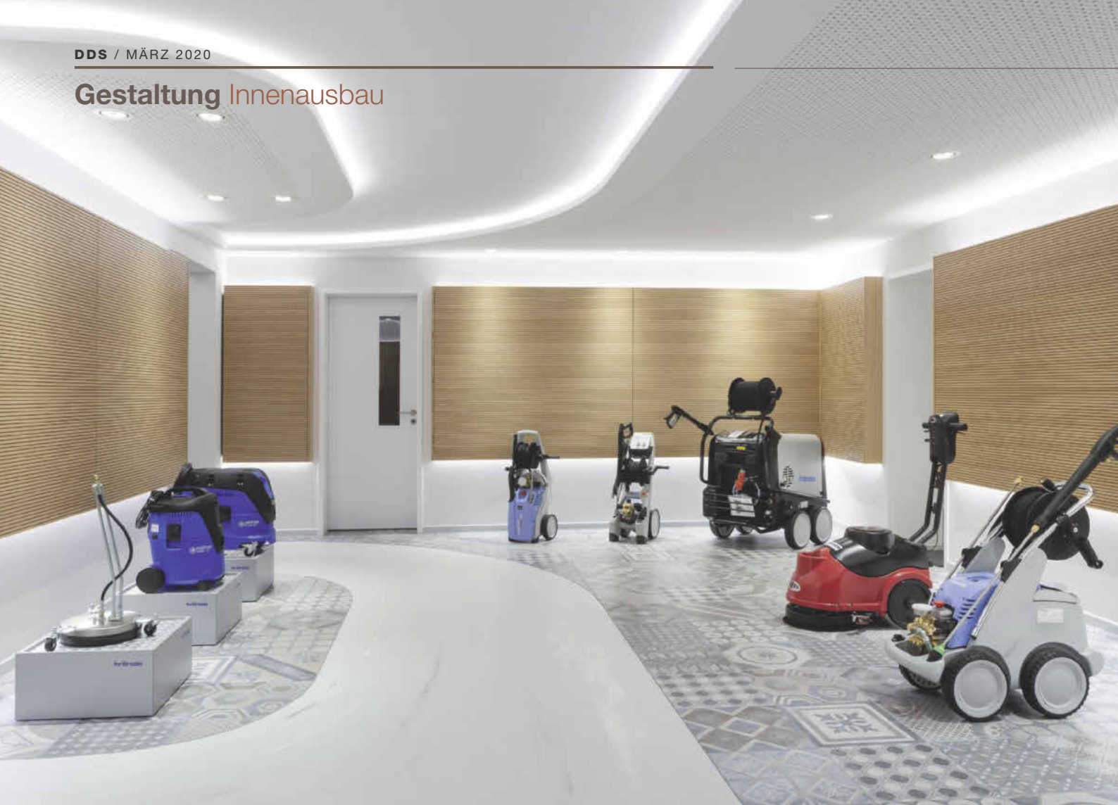
Ausstellungsbereich: Bodenparcours in marmoriertem Polyurethan, geflieste Inseln für die Geräte. Geschlitzte Akustikwände in Eiche
