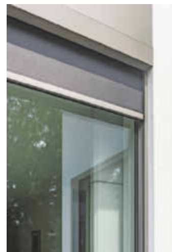
/ Der Vorbauseen Fixscreen Minimal eignet sich speziell für die Nachrüstungen von Textil-Sonnenschutz.
