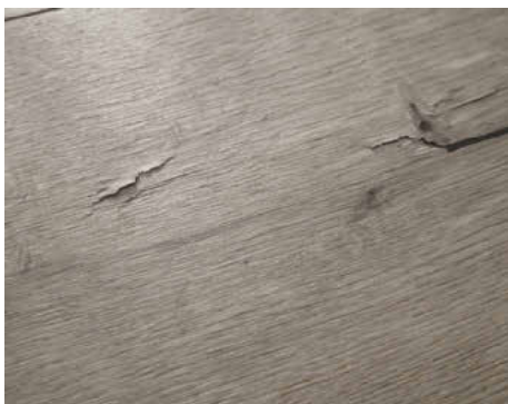
/ Schilferrisse haben schieferartige Absplitterungen, welche für Nutzer sehr gefährlich sein können.
