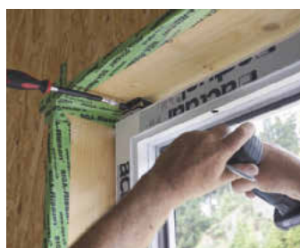
/ Auch zum schnellen Fixieren: Mit dem Hebewerkzeug lassen sich Fenster zudem zum Anschrauben „verkeilen“.
