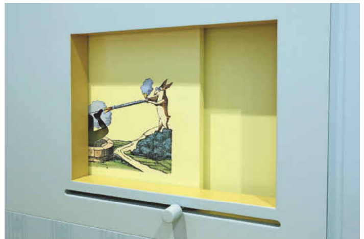
/ Bedruckte, per Wasserstrahl ausgeschnittene und verschiebbare Wandtafeln aus CDF bilden die Erzählung vom „Wilden Jäger“, der vom Hasen erlegt wird, ab.
