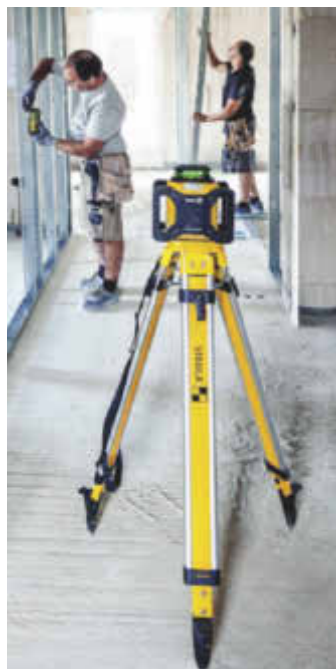
/ Der LAR 160 lässt sich horizontal und vertikal auf dem Stativ montieren.
