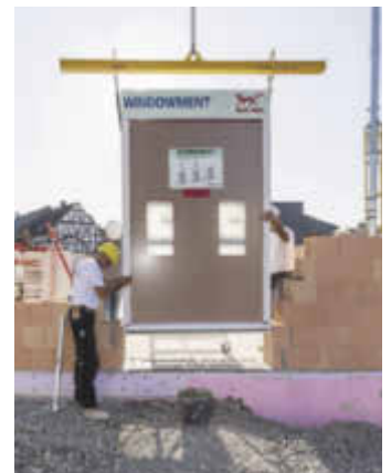
/ Schon auf der Erstbaustelle erfolgen die Logistik und die Montage von Windowment in nur rund 20 Minuten.
