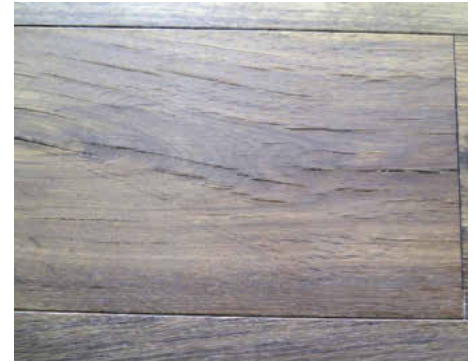
/ Haarrisse verlaufen nicht tief ins Holz und führen meist auch nicht zu weiteren Rissbildungen.
