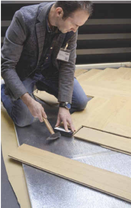
/ BM-Redakteur Stefan Kirchner überzeugt sich von der einfachen Verlegung des neuen Klicksystems für die Fischgrätverlegung.
